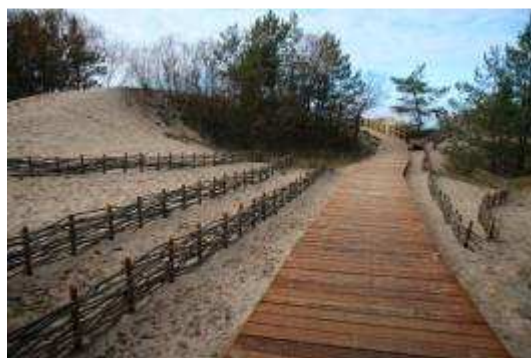
1.3.2.19. att. Promenādes galā ierīkotā dēļu laipa ar žodziņiem, kas mazinās eroziju, uzkrājot smiltis kā arī regulēs apmeklētāju pārvietošanos. Foto: I. Priedniece 29.10.2018.
