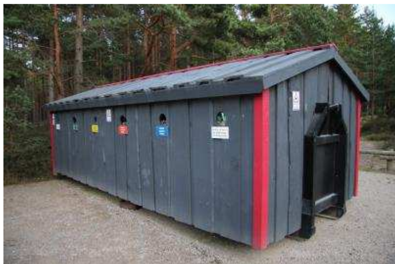
4.1.25. att. Piemērs šķirojamo atkritumu konteineriem (uzstādīts Kolkas stāvlaukumā).
