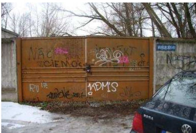
4.1.18. att. Vārti pie autostāvvietas Saivas ielā, aiz kuriem atrodas auto novietošanai potenciāli piemērota teritorija.
