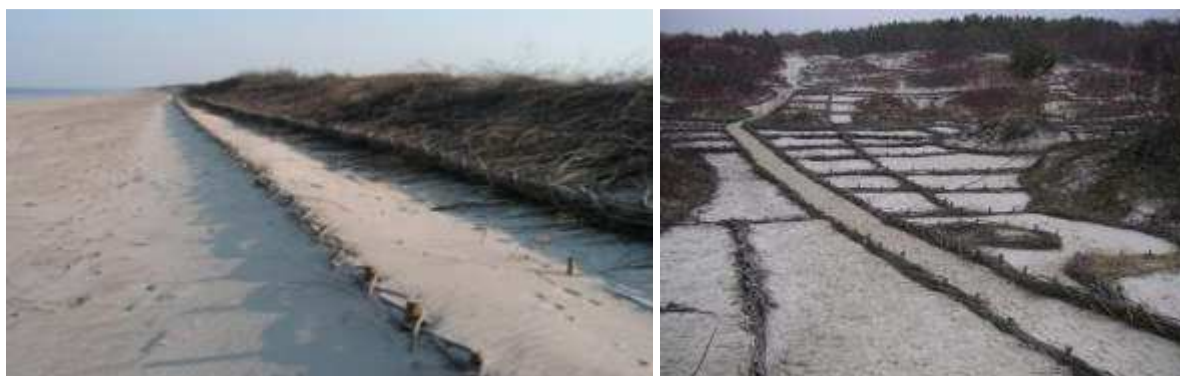
4.1.4., 4.1.5. att. Zemu kārklu zaru pinumu/sētiņu un zaru pārkļājumu izmantošana eolās akumulācijas veicināšanai un deflācijas novēršanai kāpas frontālajā daļā (attēls kreisajā pusē) un deflācijas mazināšana/atpūtnieku plūsmas organizēšana starpkāpu ieplakās (attēls labajā pusē). Foto D. Pupienis
