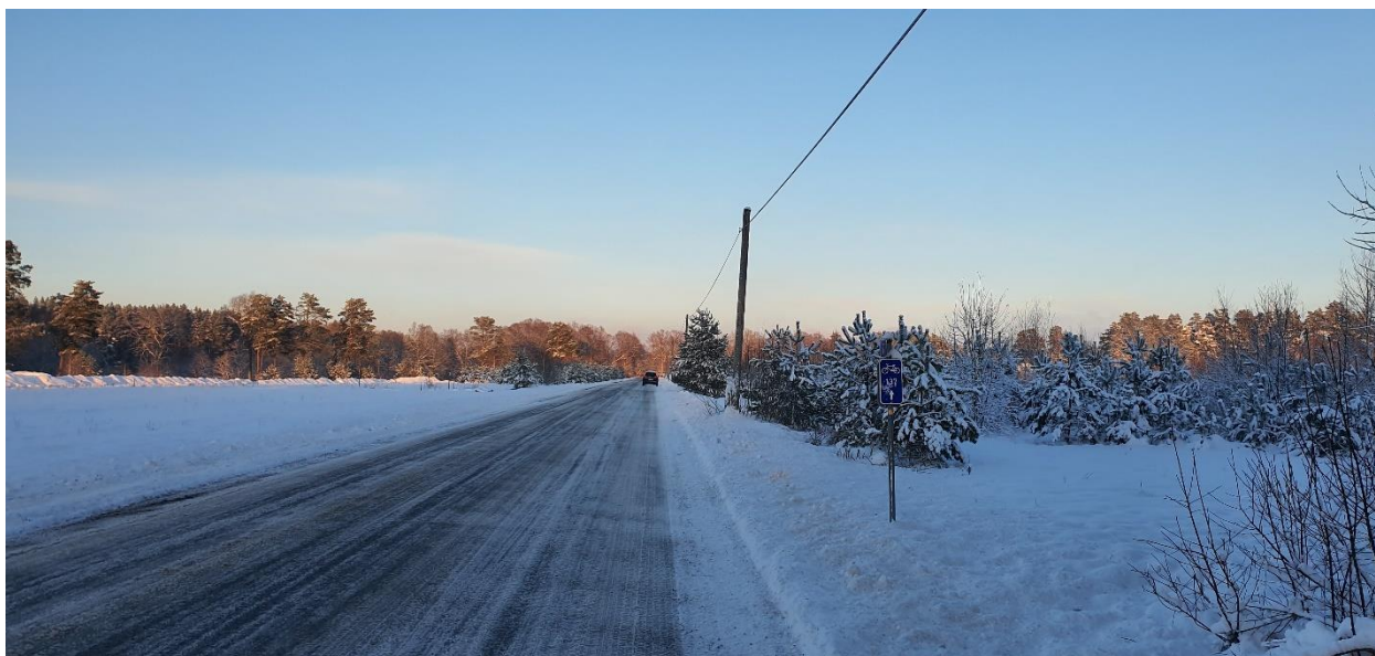
Attēls Nr. 8. Paralēli autoceļam V50 esošā elektronisko sakaru gaisvadu līnija
