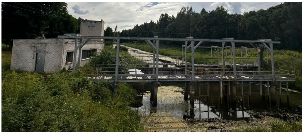
50. attēls Laveru poldera sūkņu stacija "Laveri"
