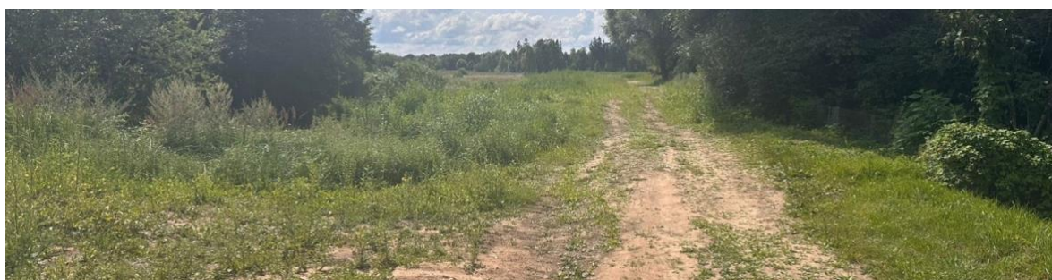
52.attēls Zeduļu dambis (2024.gada jūlijā)
