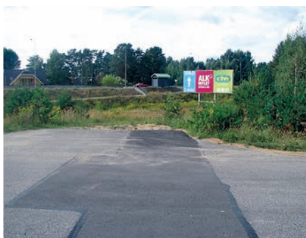
Asfaltbetona segums pēc remonta
