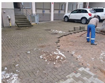
Betona bruģakmens remontdarbi
