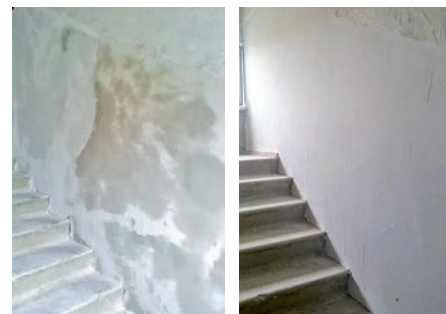
Projektā tiek uzlabota daudzdzīvokļu dzīvojamās mājas kāpņu telpa
