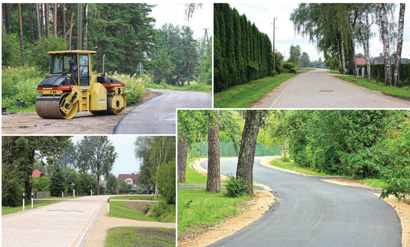
Atjaunota Baltezers iela, izbūvēta Saules iela, izbūvēts jauns grants segums Depo, Bērzu, Pļavu, Dārza, Druvas, Ķiršu, Čiekuru, Nūrnieku, Priežu, Krūkļu, Graudu, Nostūrīšu, Mālnieku ielām, Virpnieku un Bukultu, kā arī Upmalu ceļiem.
