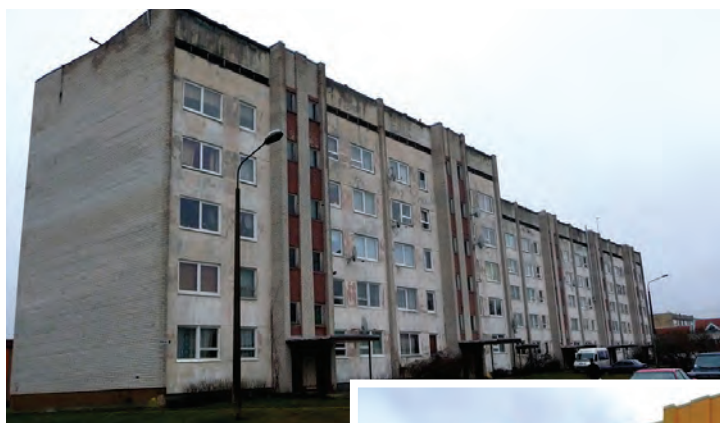
Daudzdzīvokļu nams Pirmajā ielā 40 pirms renovācijas
